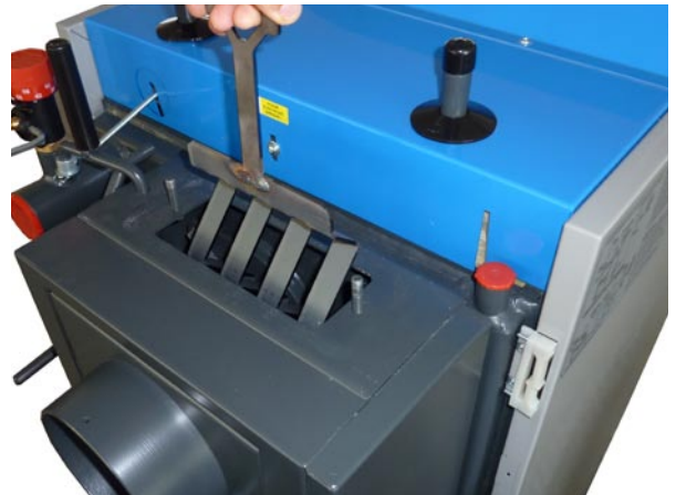
Ausziehen von Abgasbremser bei der Reinigung unter im hinteren Putzdeckel im hinterem Abgaskanal
