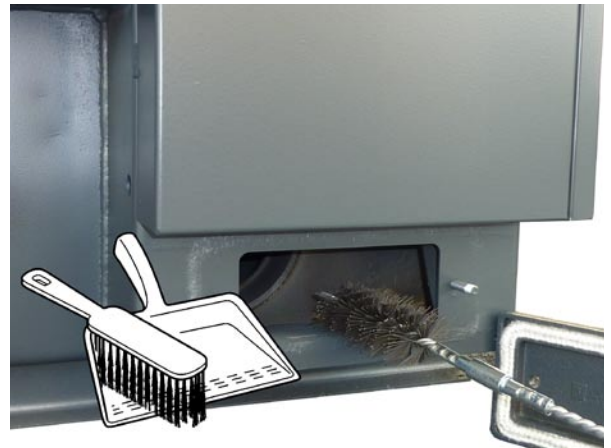
Vorführung der Reinigung des Rauchkanals mit Drahtbürste.
